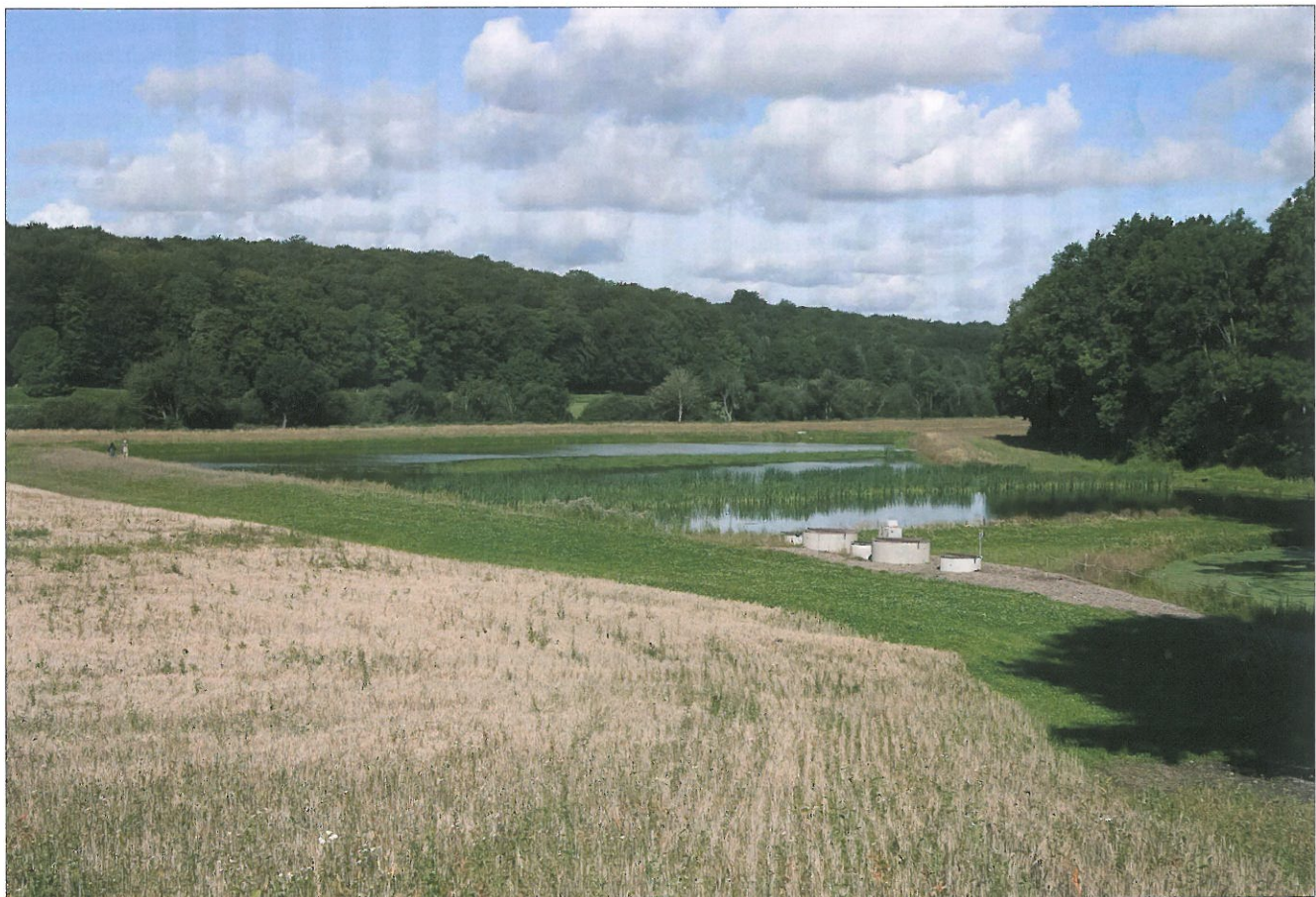
Figur 2. Konstrueret vådområde (1 ha) med overfladestrømning renses drænvandet fra 100 ha landbrugsjord. I forgrunden ses drænbrønde med fosforfilter der afprøves i forskningsrådsprojektet SupremeTech ( www.supremetech.dk ). Foto: Flemming Gertz
